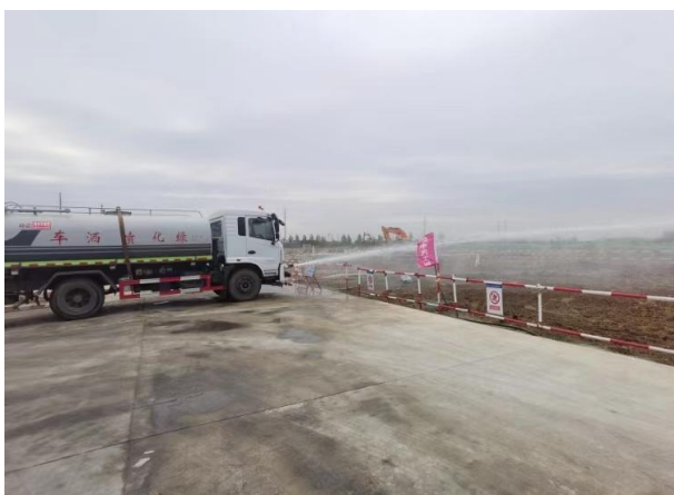
场地内洒水降尘
